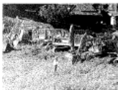
崩壊による人命被害
